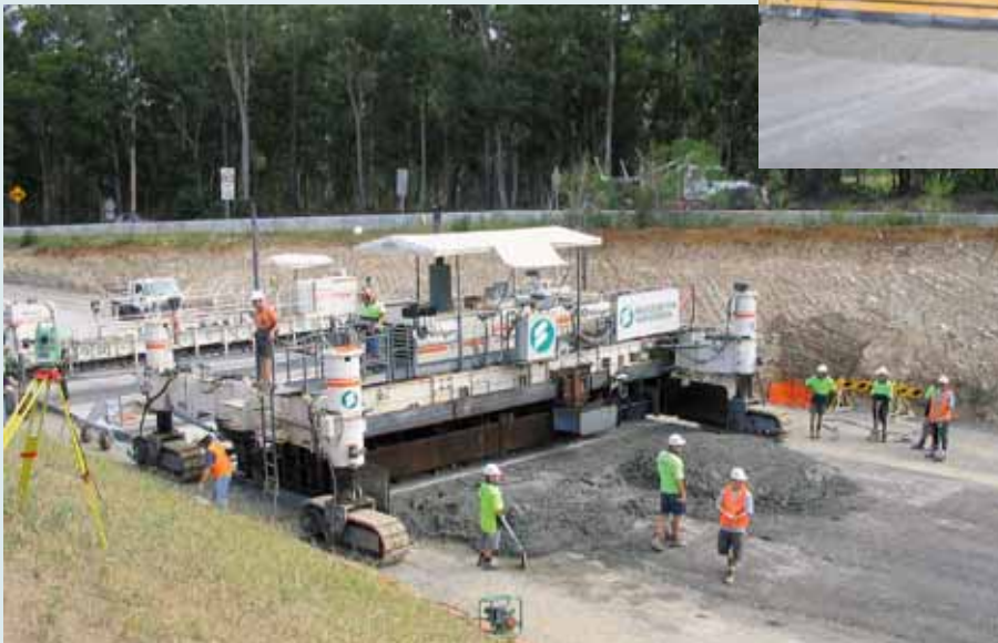
Une machine à coffrage glissant Wirtgen SP1600 contrôlée par le système Leica LMG-S 3D lors de la pose d'un revêtement de 10,5 mètres de large
