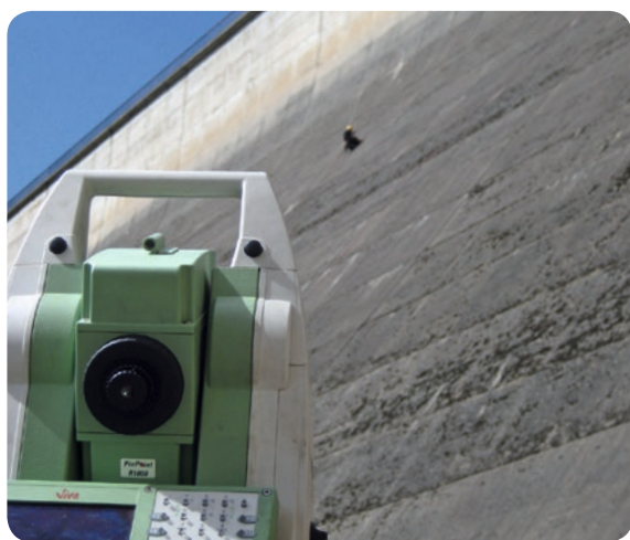
■ Abstecken der Punkte auf die Staumauer.
