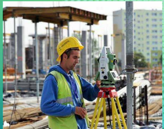
Bau eines Einkaufszentrums, Polen
